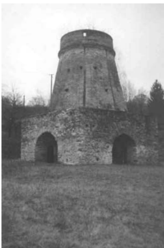
Fig. 2. Charcoal blast furnace in Sirk – Červeňany (Coburg)
